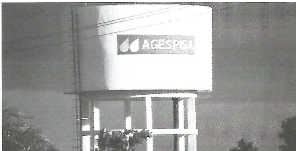
Foto 03 – Reservatório elevado de distribuição – Fonte: Internet, 2020.
