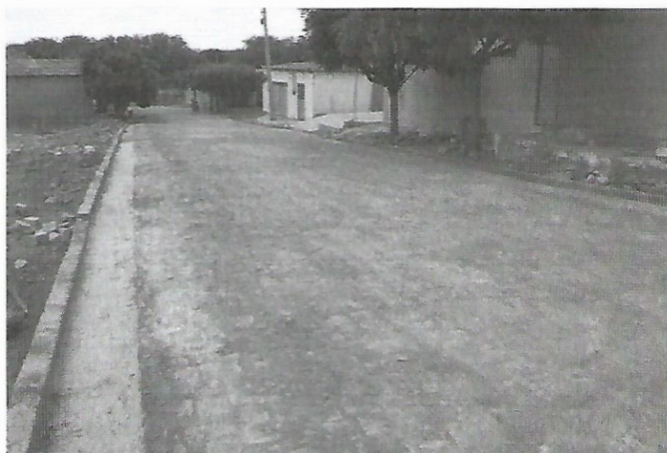
Foto 01 – Pavimentação de ruas na área urbana.
